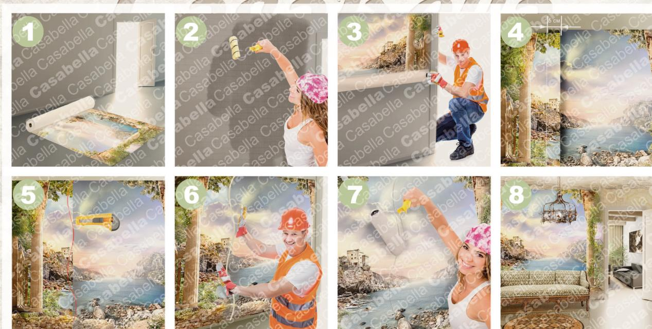
1. Разложить полотно на чистой ровной поверхности. Произвести осмотр и замер полотна.
